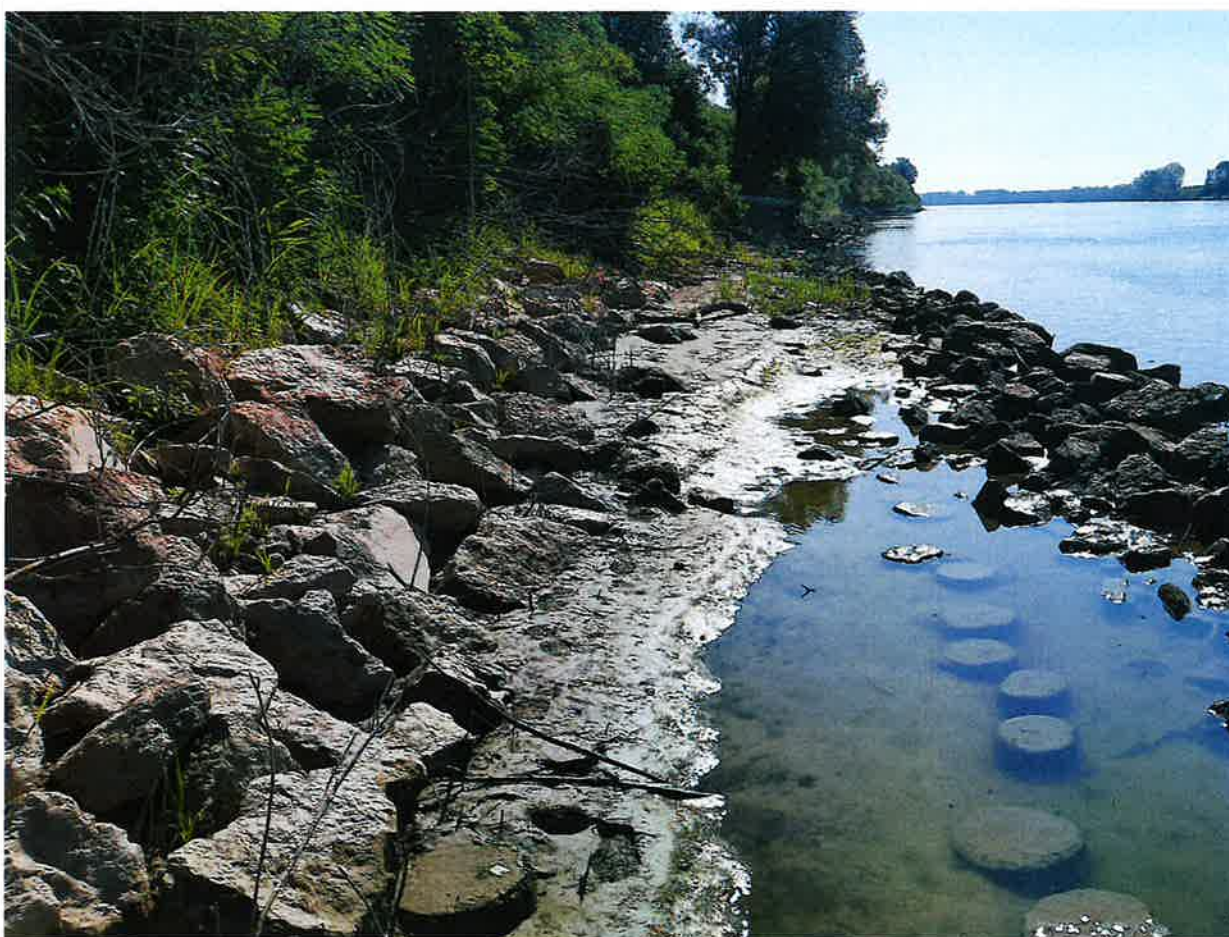
Foto n. 8 - Ripresa dalla bassa sponda - tratto 1 – parte di monte – Agosto 2025 – particolare della palificata che nel tratto di valle risulta interrata
