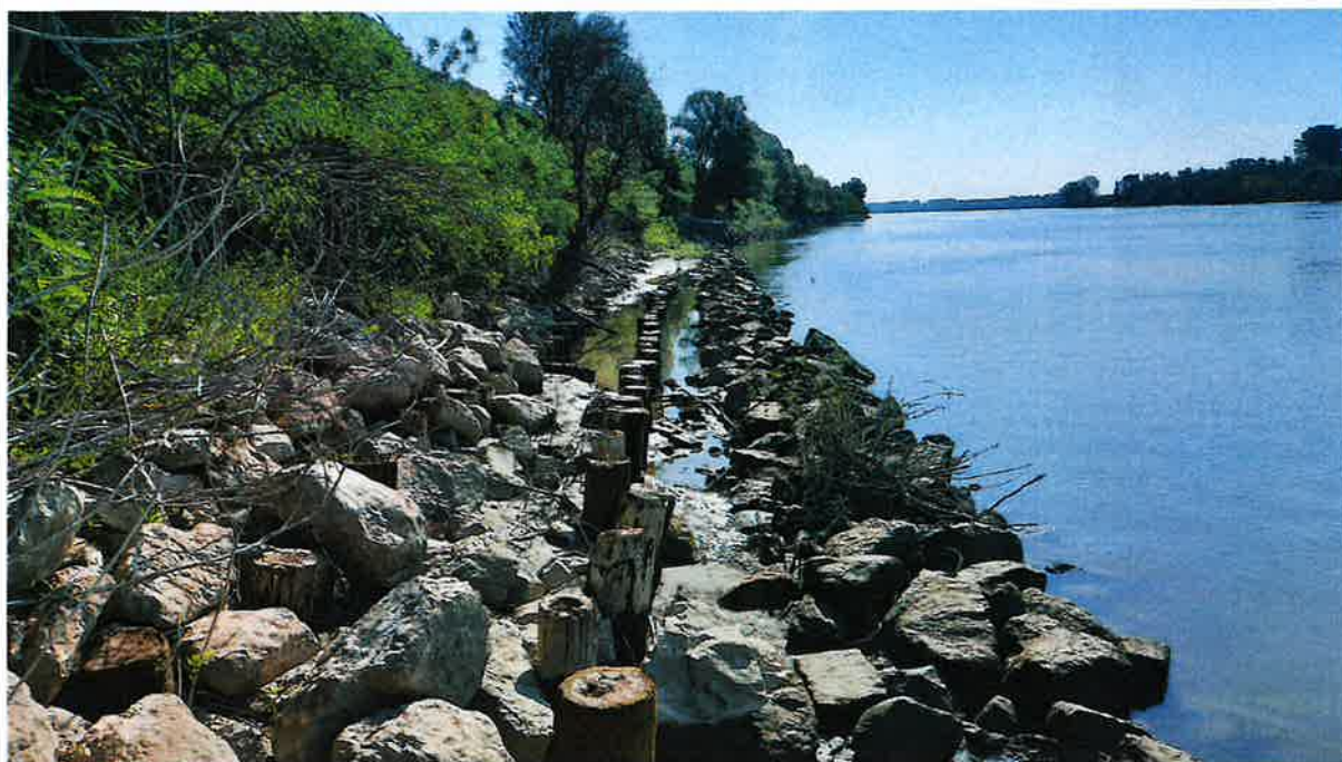
Foto n. 7 - Ripresa dalla bassa sponda - tratto 1 – parte di monte – Agosto 2025 – particolare della palificata
