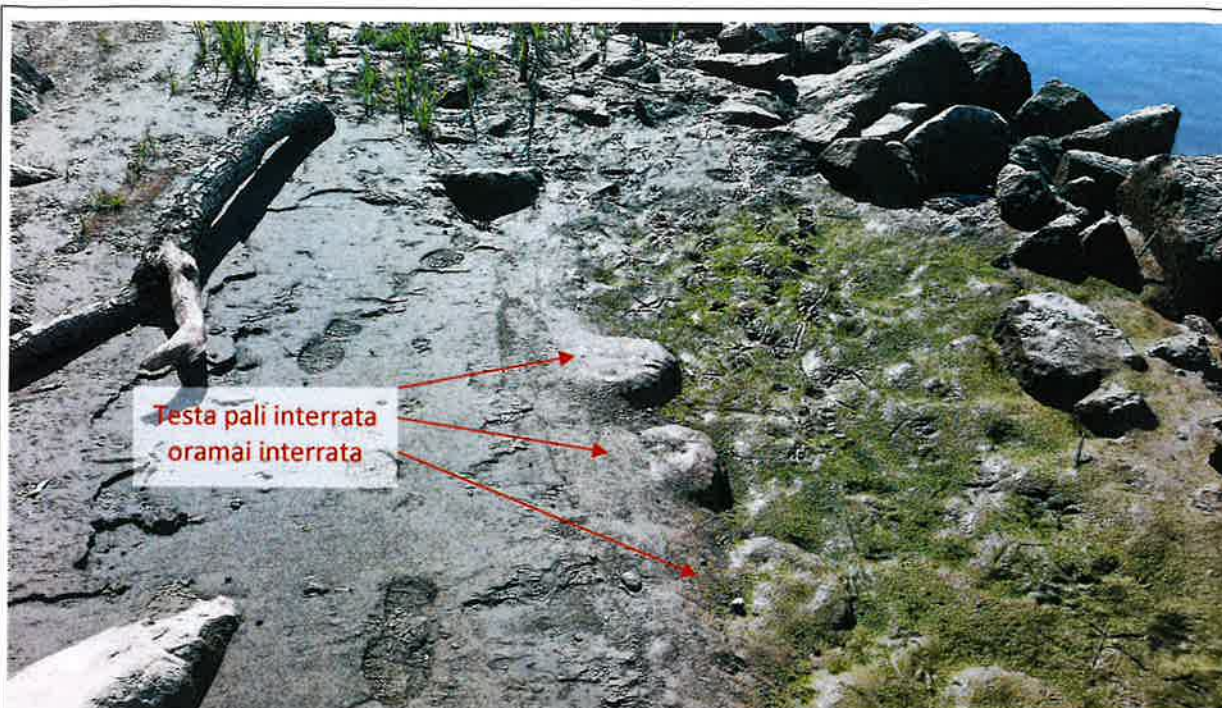
Foto n. 9 - Ripresa dalla bassa sponda - tratto 1 – parte di valle – Agosto 2025 – particolare della palificata: alcuni pali presentano la testa quasi completamente interrata
